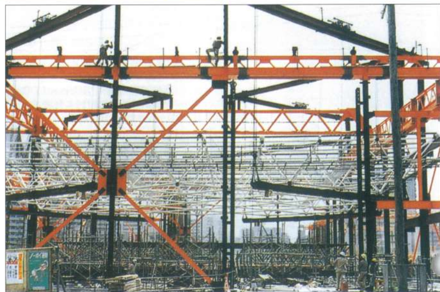
特殊足場の引き上げ用 FE
